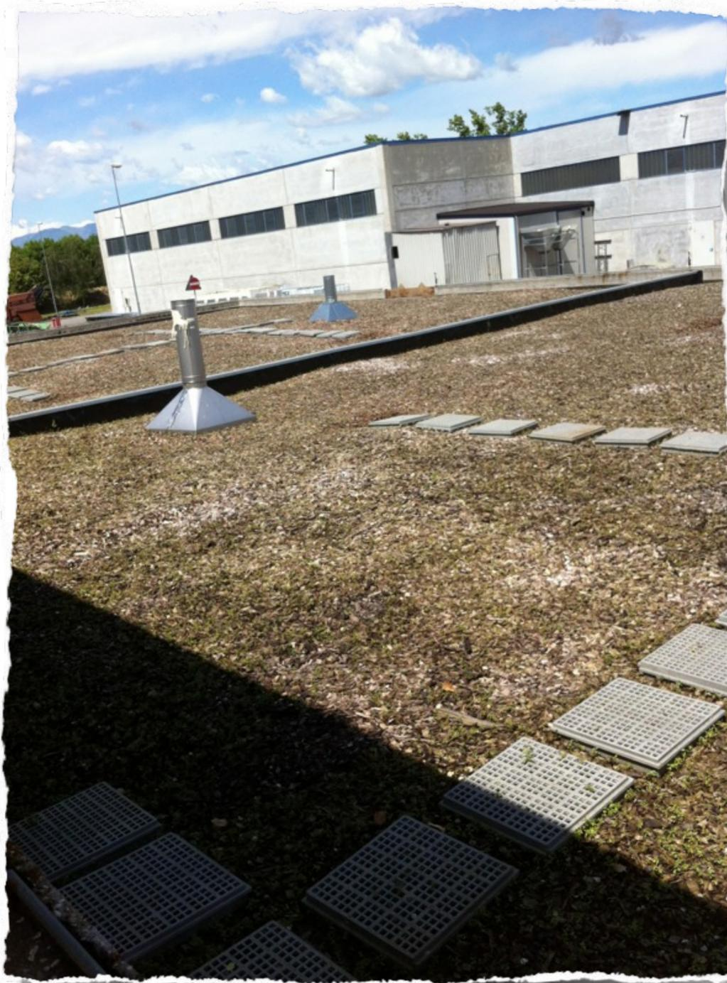
*BIOFILTRI PER IL TRATTAMENTO DELL'ARIA DI ASPIRAZIONE*
